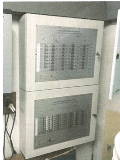
รูปภาพที่ 2.46 แผงควบคุม FCP
