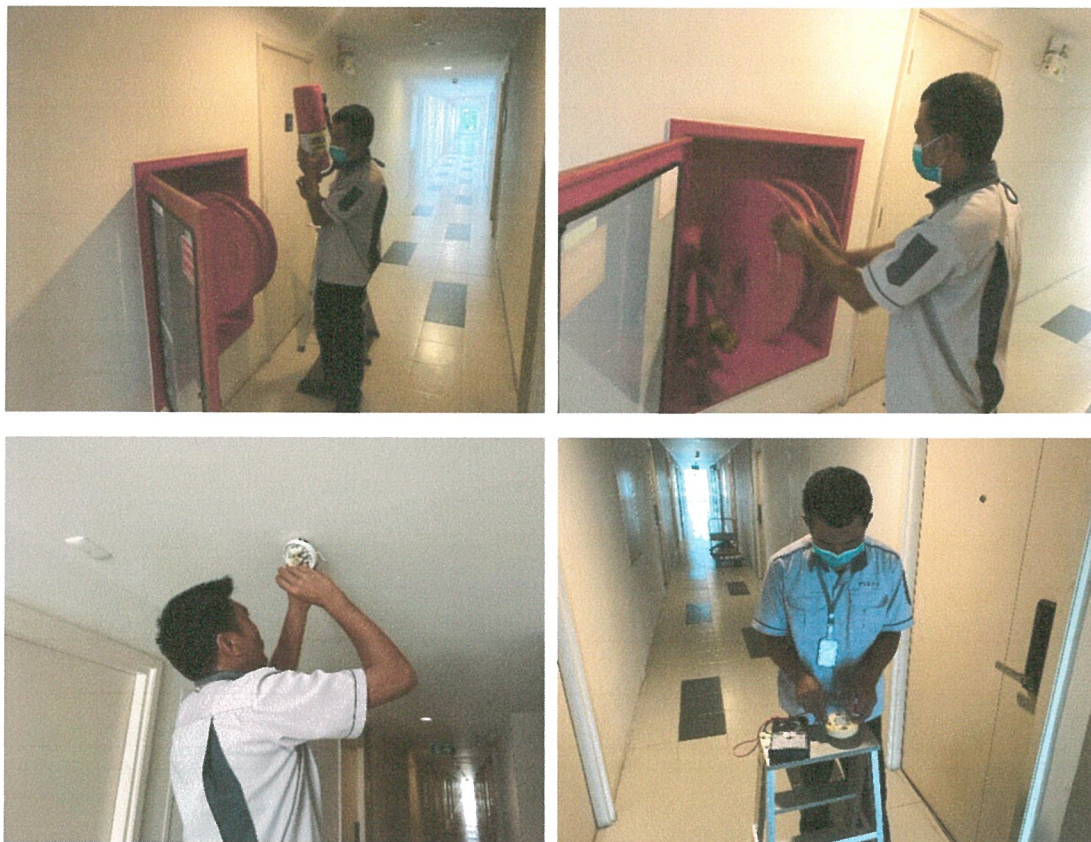
รูปภาพที่ 2.48 การตรวจสอบอุปกรณ์ป้องกันและแจ้งเตือนอัคคีภัย
