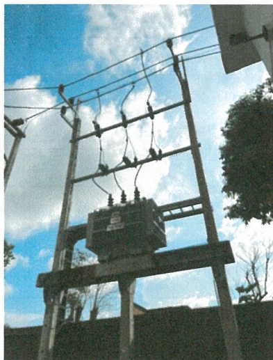
รูปภาพที่ 2.16 หม้อแปลงไฟฟ้า
